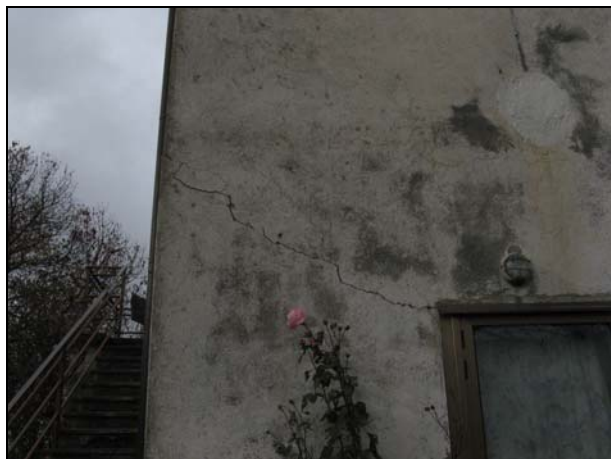
Foto 1 – Campotenese. Lesioni di 2° grado in edificio rurale in muratura.
