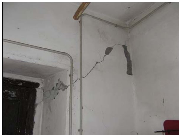
Foto 1 – Campotenese. Lesioni di 2° grado in edificio rurale in muratura.
