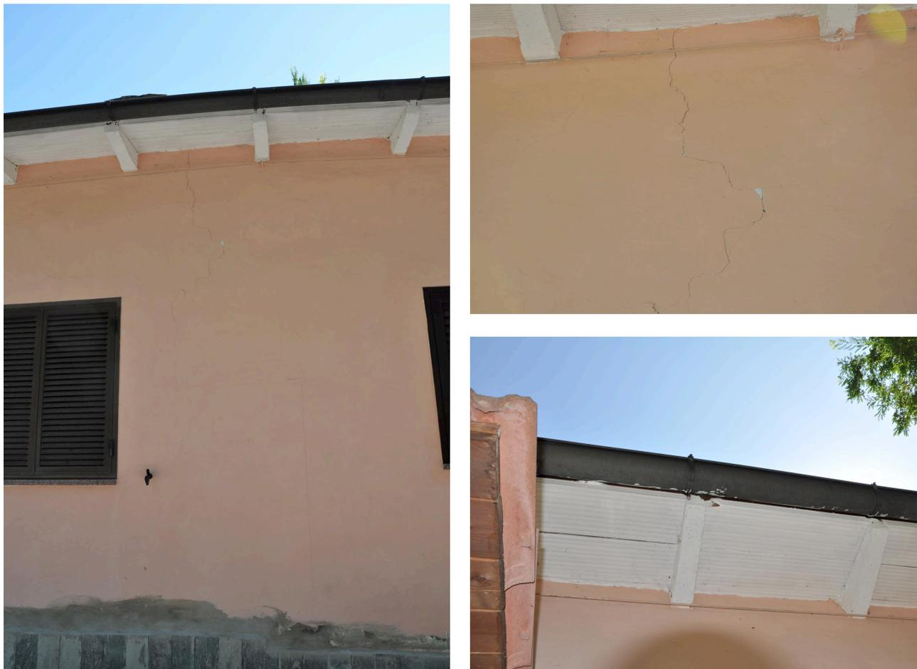
Fig. 3 – Danni lievi ad un edificio in muratura nella località Cabelli (comune di Santa Sofia – FC) a seguito delle scosse del 12 luglio 2011 (foto di Enrico Serpelloni)
