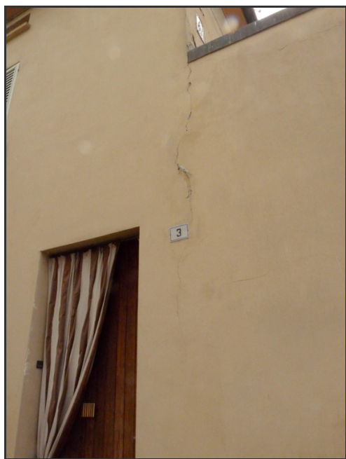
Foto 1-2 Tracce di lesioni superficiali (in genere preesistenti) su alcuni edifici del centro storico di Sermide (MN).
