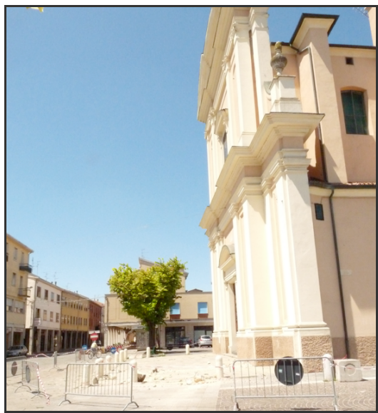
Foto 3-4 Crollo di elemento decorativo instabile dalla facciata della chiesa di Poggio Rusco (MN).
