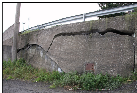
Figura 18 – S. Maria la Stella, via Floridia: interruzione dell'asse viario di accesso al paese (a sin.) per rottura del muro di sostegno del rilevato stradale (a dest.).
