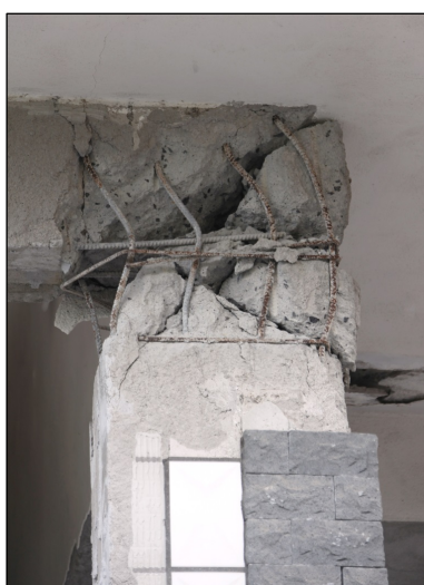
Figura 4 – Mazzasette, edificio in c.a. (classe di vulnerabilità C) collocato sulla faglia: si nota la rottura completa dei pilastri, il loro fuori-piombo ed il crollo delle tramezzature al piano terra (grado di danno 4).
