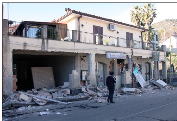
Figura 5 – Rottura dei tramezzi in edifici in c.a. (classe C): Pennisi ( a sin.); Fleri (a dest.).
