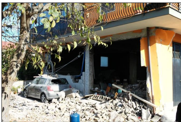
Figura 5 – Rottura dei tramezzi in edifici in c.a. (classe C): Pennisi ( a sin.); Fleri (a dest.).
