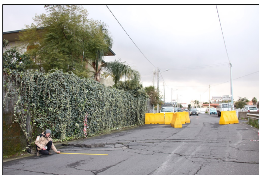
Figura 18 – S. Maria la Stella, via Floridia: interruzione dell'asse viario di accesso al paese (a sin.) per rottura del muro di sostegno del rilevato stradale (a dest.).
