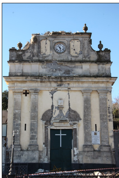
Figura 9 – Fleri, Chiesa Madre: particolari del danneggiamento alla facciata della vecchia chiesa; si nota anche il danneggiamento alla nuova struttura costruita dopo il sisma del 1984.
