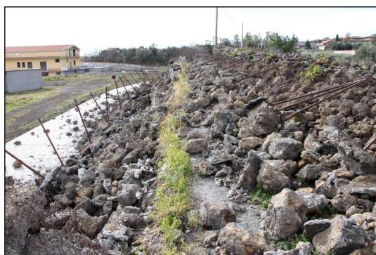
Figura 19 – C.da Testa di vipera: il crollo di un muro di recinzione a secco ostruisce interamente una strada interpoderale.
