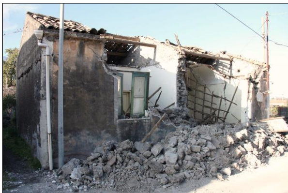
Figura 8 – Crollo di edifici in pietra grezza (classe A): Pennisi ( a sin.); Fleri (a dest.).
