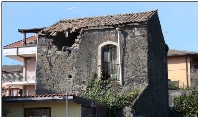
Figura 14 – S. Maria la Stella: danno di grado 3 ad un edificio rurale in pietra grezza (classe A).
