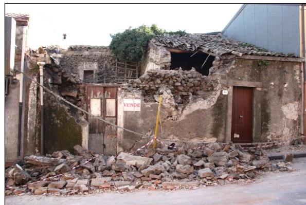
Figura 8 – Crollo di edifici in pietra grezza (classe A): Pennisi ( a sin.); Fleri (a dest.).
