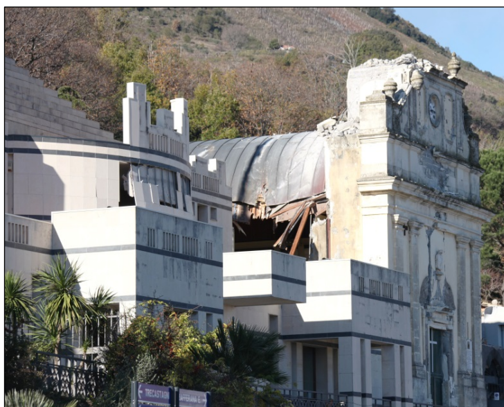
Figura 9 – Fleri, Chiesa Madre: particolari del danneggiamento alla facciata della vecchia chiesa; si nota anche il danneggiamento alla nuova struttura costruita dopo il sisma del 1984.
