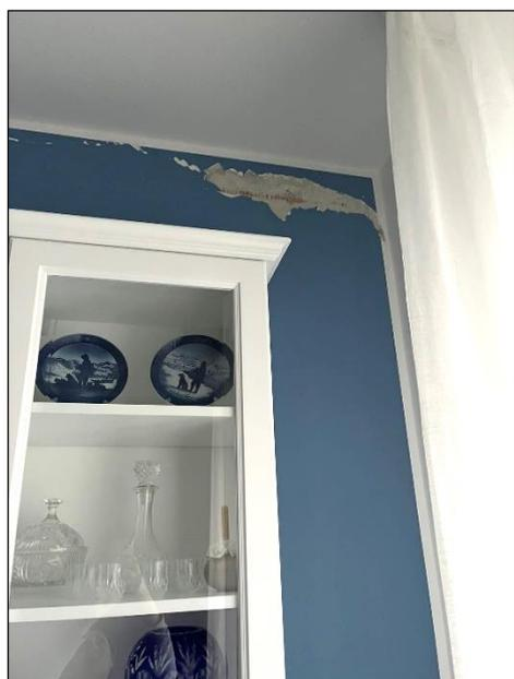
**Figura 1.** Lipari centro: distacco tra trave e tramezzo in un edificio in C.A.
