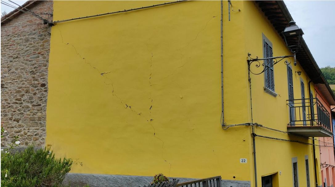
Fig. 8. Lesioni su muratura in un edificio a Trezzio (FC)
