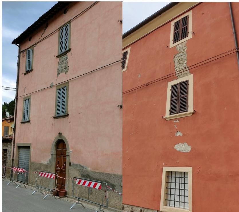
Fig. 10. Lesioni e distacchi di intonaci su muratura in vecchie case a Trezzano (FC)
